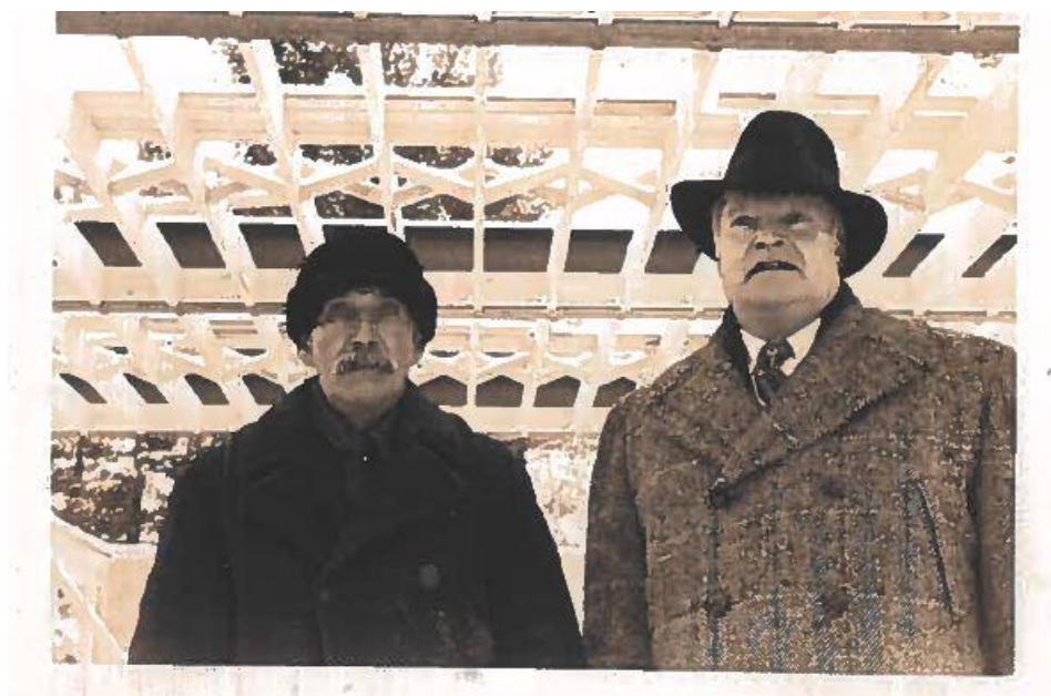
Le constructeur, Fred Booth et le concepteur, Henri Pontbriand - le deuxième clubhouse en construction / Photographie provenant des archives de la famille Finlayson transmise par Carol Finlayson
